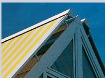
El montaje en lo alto con apliques de sujeción adicionales.
